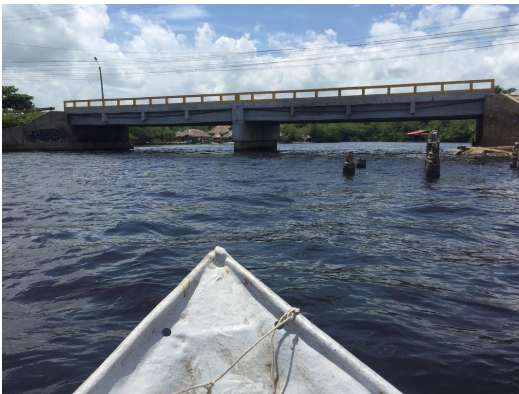
Ilustración 1. Zona marítima, antes del puente que conduce al ingreso de la Ciénaga de la Caimanera.
