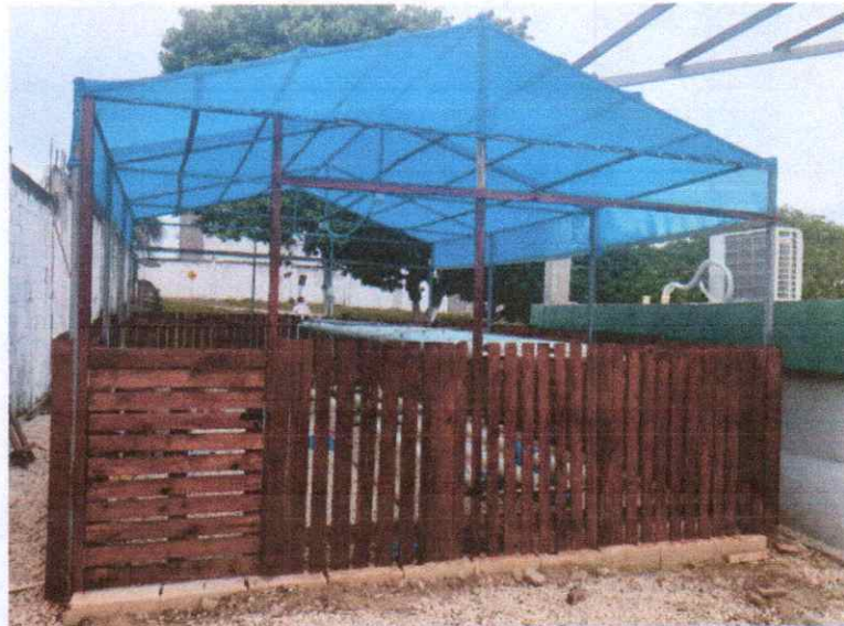
Figura 25. Estructura final externa del prototipo de invernadero hidropónico fuente: autores del proyecto.
