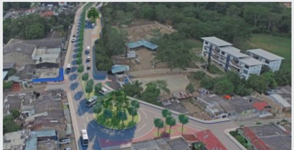
Par vial San Carlos. Foto: Metro Sabanas
